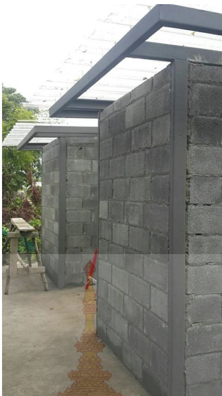
ภาพที่ 4.7 หลังคาโรงอบแห้งจำลองใส่เพื่อให้แสงแดดส่องถึงพื้นคอนกรีตบล็อก
