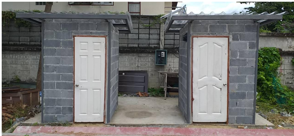
ภาพที่ 4.3 โรงอบแห้งจำลองมาตรฐานและโรงอบแห้งจำลองที่มีระบบระบายอากาศด้วยพลังงานแสงอาทิตย์
