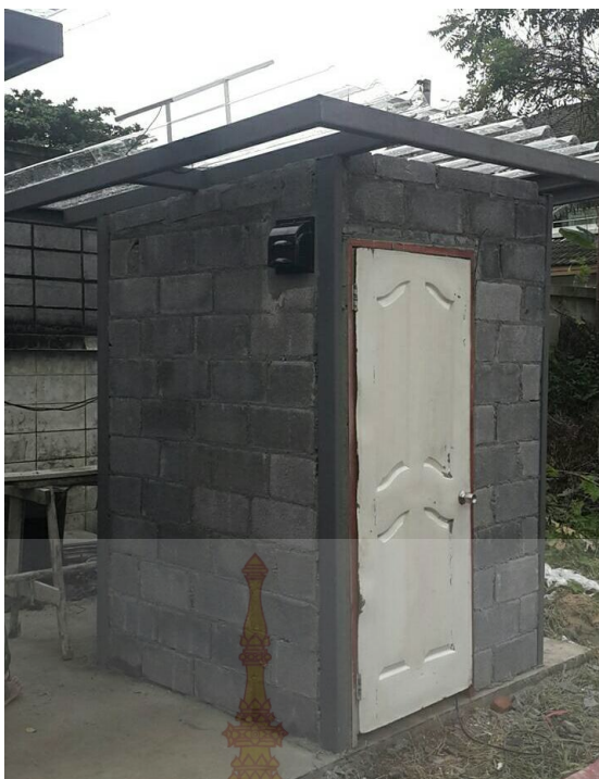
ภาพที่ 4.5 โรงอบแห้งจำลองที่มีระบบระบายอากาศด้วยพลังงานแสงอาทิตย์
