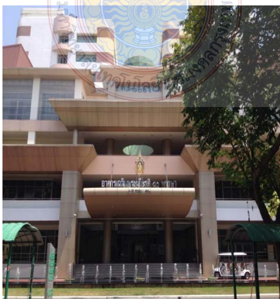
ภาพที่ 4.7 อาคารเฉลิมพระเกียรติ 80 พรรษา (อาคาร 52)
