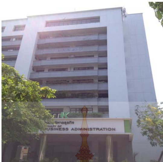
ภาพที่ 4.6 อาคารคณะบริหารธุรกิจ (อาคาร 50)
