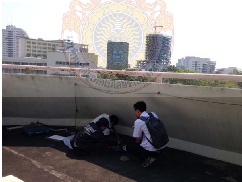
ภาพที่ ก.8 ทำการทดสอบอาคารคณะวิศวกรรมศาสตร์ (อาคาร 48)
