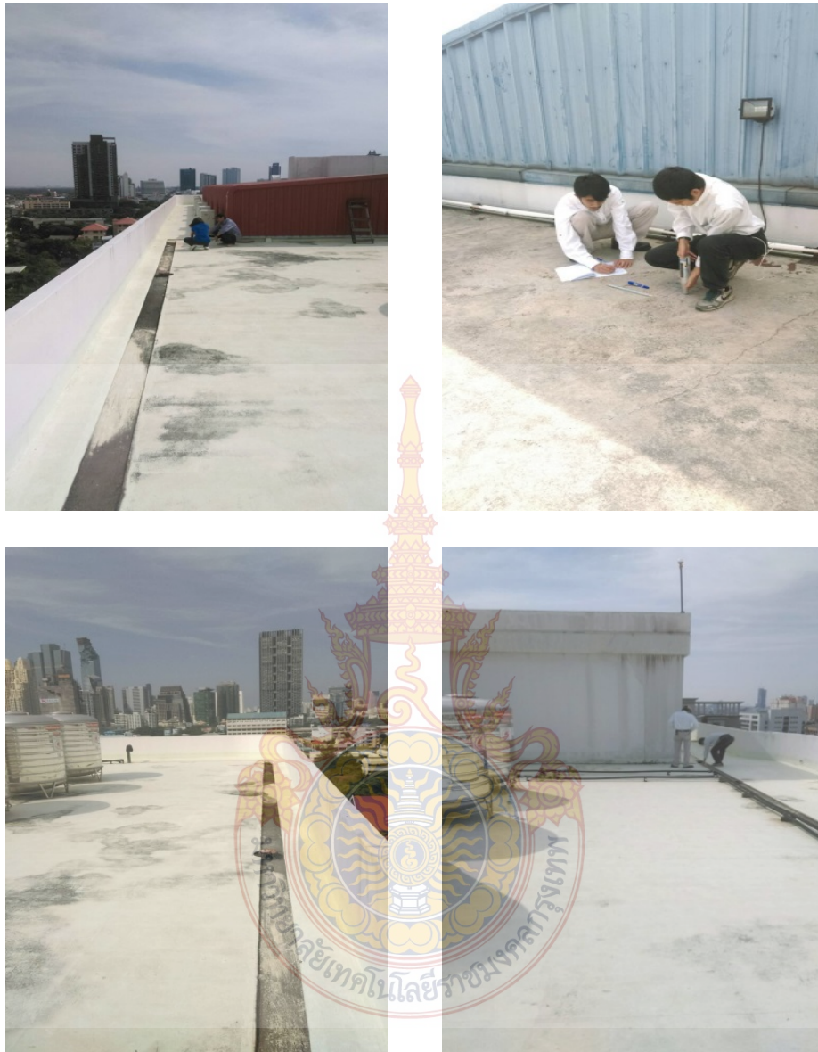
ภาพที่ ก.1 (ต่อ) การทดสอบกำลังอัดด้วย Schmidt Hammer พื้นชั้นดาดฟ้าอาคาร
