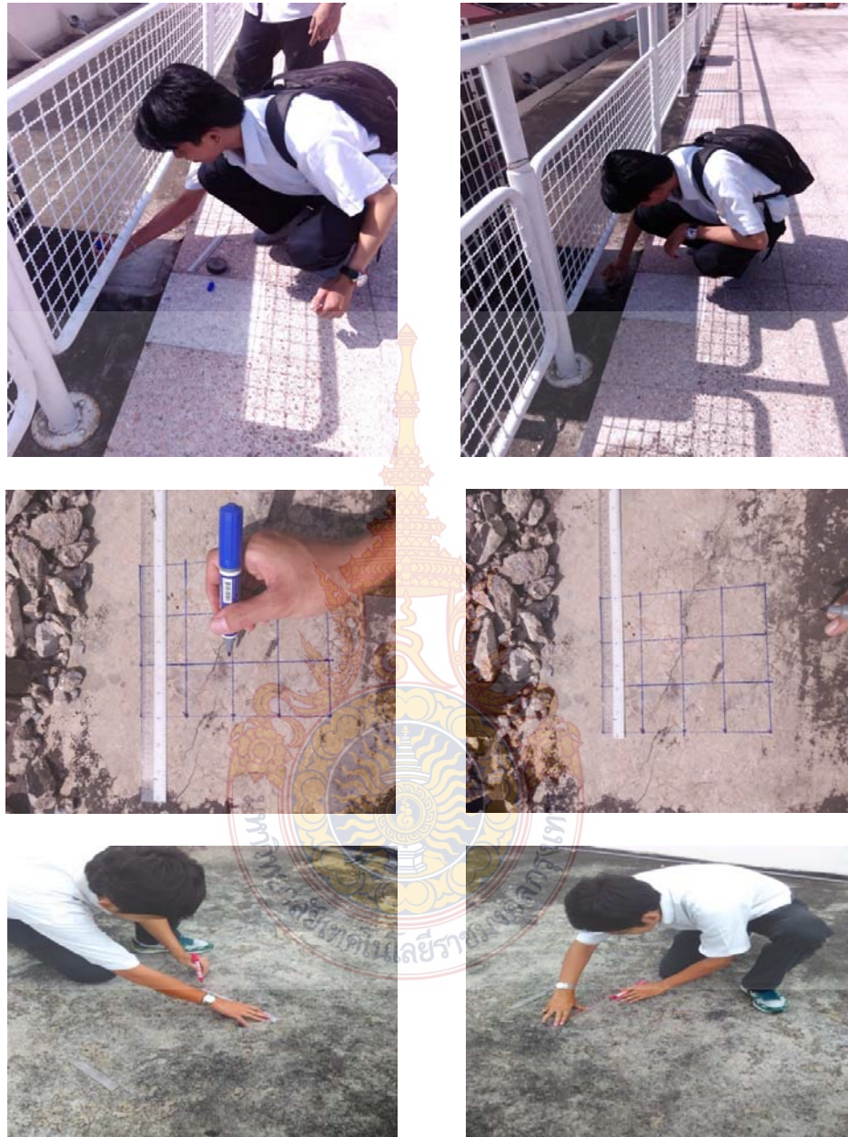
ภาพที่ ก.1 การทดสอบกำลังอัดด้วย Schmidt Hammer พื้นชั้นดาดฟ้าอาคาร
