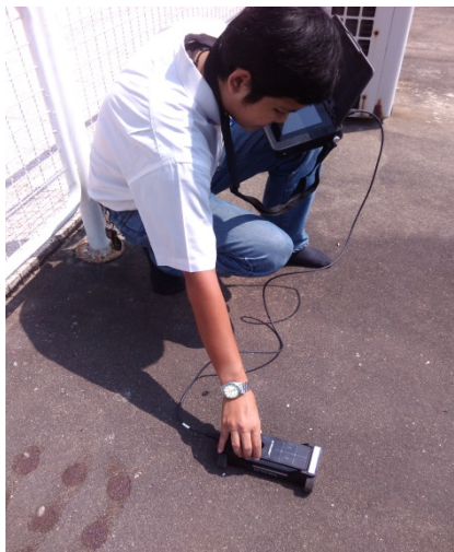
ภาพที่ 4.21 การวัดขนาดเหล็กเสริมพื้นชั้นดาดฟ้าอาคาร
