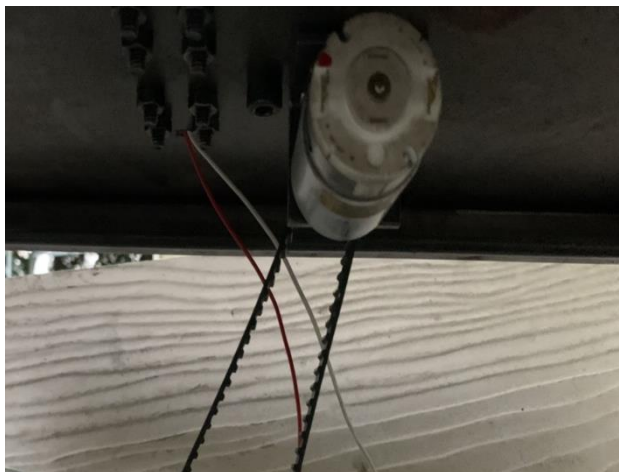
ภาพที่ 3.10 แสดงการติดตั้งชุดเจนเนอเรเตอร์
