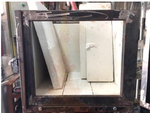
ภาพที่ 3.9 ติดตั้งแผ่นกันความร้อนแคลเซียมซิลิเกตบอร์ด
