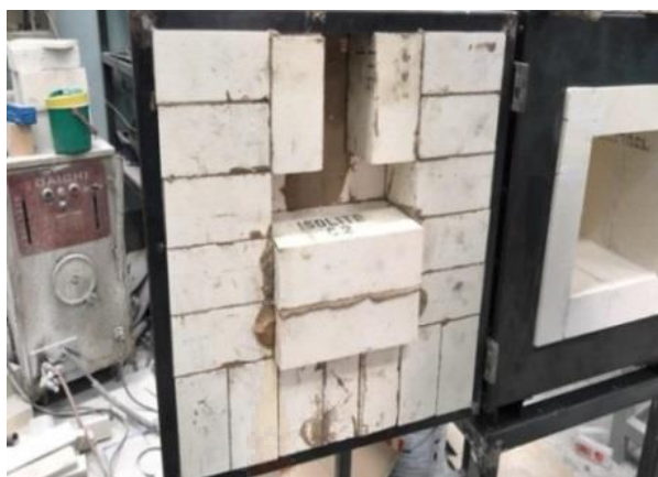
ภาพที่ 3.5 ภาพการติดตั้งฉนวนทนความร้อนที่ฝ้าด้านหน้าเตา
