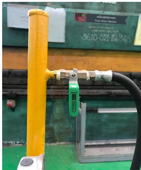
ภาพที่ ข 12 ปิดวาล์วท่อลำเลียงเชื้อเพลิงแก๊สปิโตรเลียมเหลว
