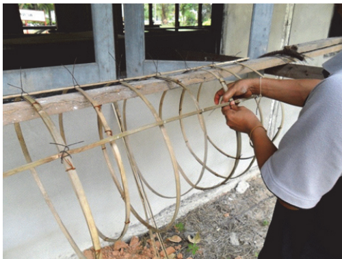
ภาพที่ 2 การเตรียมโครงไม้ไผ่สำหรับเสริมในท่อ คอนกรีต
