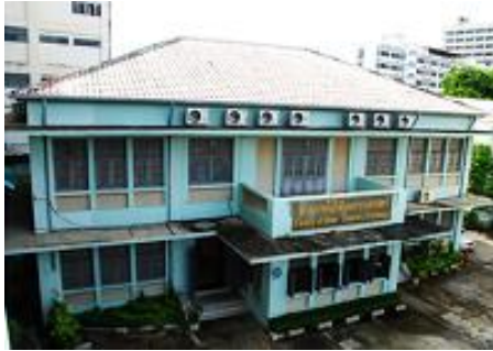
ภาพที่ 7 อาคารสำนักงาน
