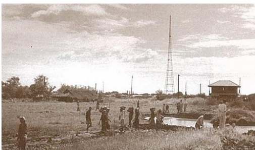
ภาพที่ 2 การก่อสร้างอาคารวิทยาลัยเทคนิคกรุงเทพ
