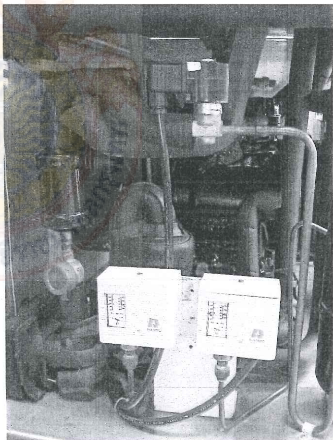
รูปที่ 20 ติดตั้ง Pressure Gauge
