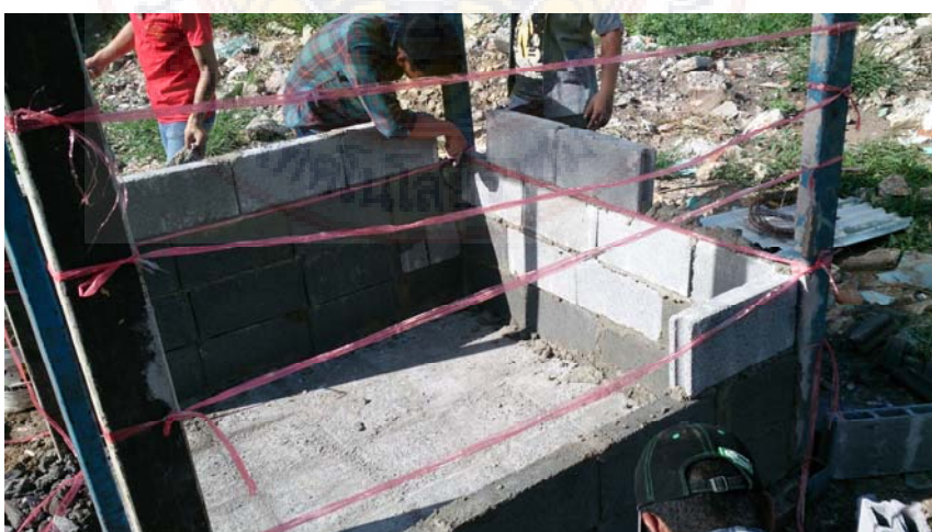
ภาพที่ 4.26 การก่อผนังโรงอบแห้งจำลอง
