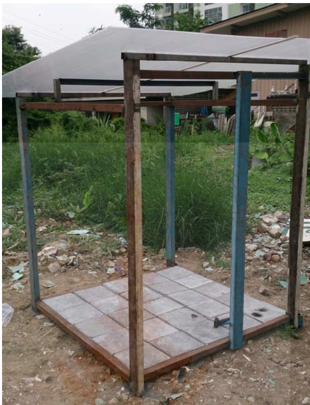
ภาพที่ 4.27 หลังคาโรงอบแห้งจำลองใส่เพื่อให้แสงแดดส่องถึงพื้นคอนกรีตบล็อก
