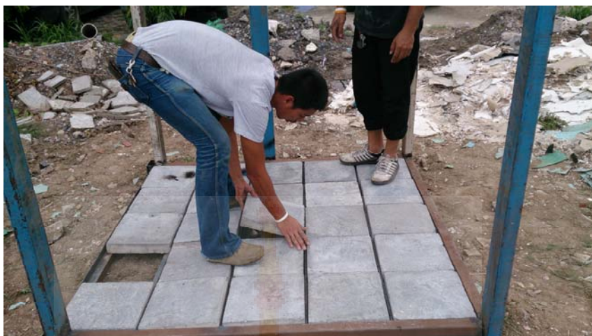
ภาพที่ 4.24 การวางแผ่นคอนกรีตบล็อกปูพื้นโรงอบแห้งจำลอง
