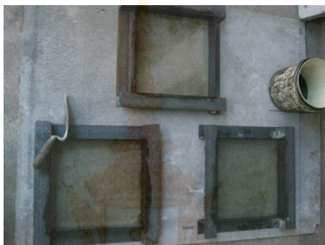
ภาพที่ 3.7 การเตรียมแบบหล่อ และ ทาน้ำมันที่แบบ
