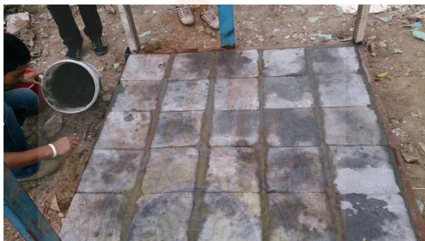
ภาพที่ 4.25 ขาแนวแผ่นคอนกรีตบล็อกปูพื้นโรงอบแห้งจำลอง
