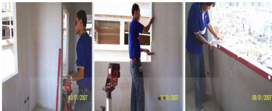
ภาพที่ 2.2 ภาพตัวอย่างการสำรวจพื้นที่สำหรับงานติดตั้งกระจก – อะลูมิเนียม
