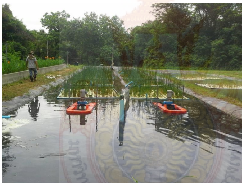
รูปที่ 4.6.9 แพกกกลอยน้ำร่วมกับการเติมอากาศ
