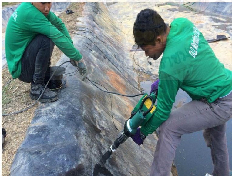
รูปที่ 4.6.3 การซ่อมแซมบ่อ
