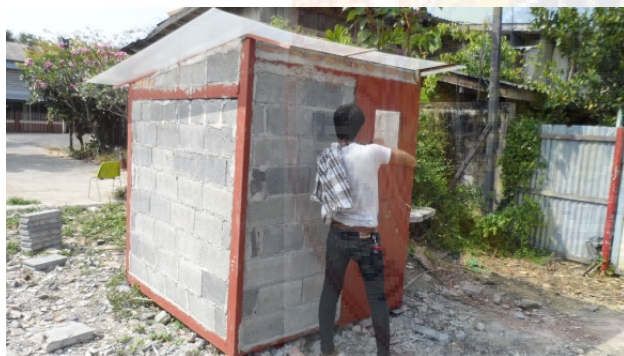
ภาพที่ 3.15 โรงอบแห้งโดยใช้คอนกรีตสะสมความร้อนเป็นฐานและผนังคอนกรีตบล็อกผสมเกล็ดและยูคาลิปตัส
