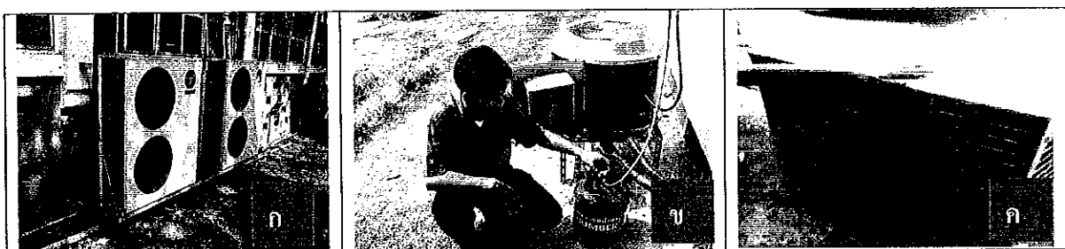
รูปที่ 3.2(ก) ดำรงขนาดความจุ (ข) เติมสารทำความเย็น และ (ค) ทำความสะอาดชุดควบแน่น
