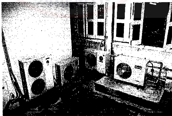
รูปที่ 2.22 แสดงลมร้อนที่ระบายออกจากชุดควบแน่นที่เป่าเข้าหาชุดควบแน่นอีกชุดหนึ่ง
