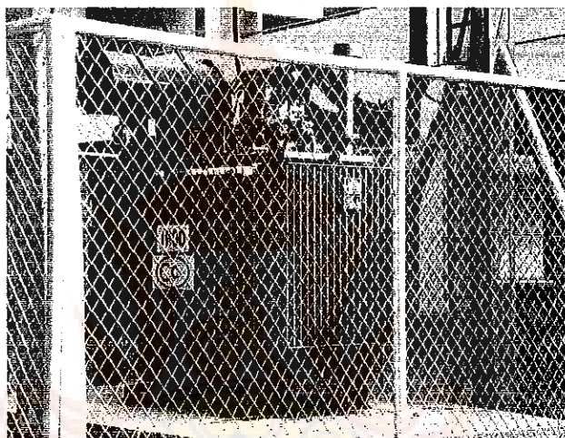
รูปที่ 2.1 หม้อแปลงไฟฟ้า ขนาด 500 kVA
