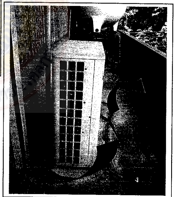
รูปที่ 4.10 (ก) และ (ข) ชุดควบแน่นสกปรกมีฝุ่นเกาะ (ค) หน่วยแฟนคอยล์ และ (ง) งบประมาณความร้อนย้อนกลับเข้าสู่ชุดควบแน่น
